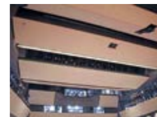
中ホール天井
